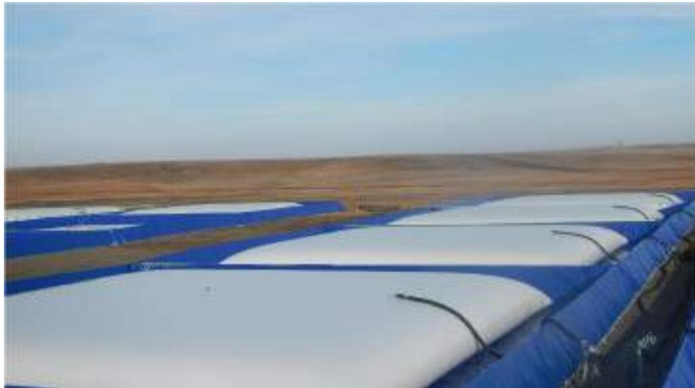
Рисунок 1 – «Типовой резервуарный парк с использованием эластичных резервуаров»
