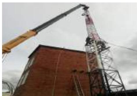
Стыковка секций и обваривание стыков АМС
