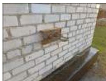
Устройство для крепления штурмовой лестницы, карабинов крюков и задержек
