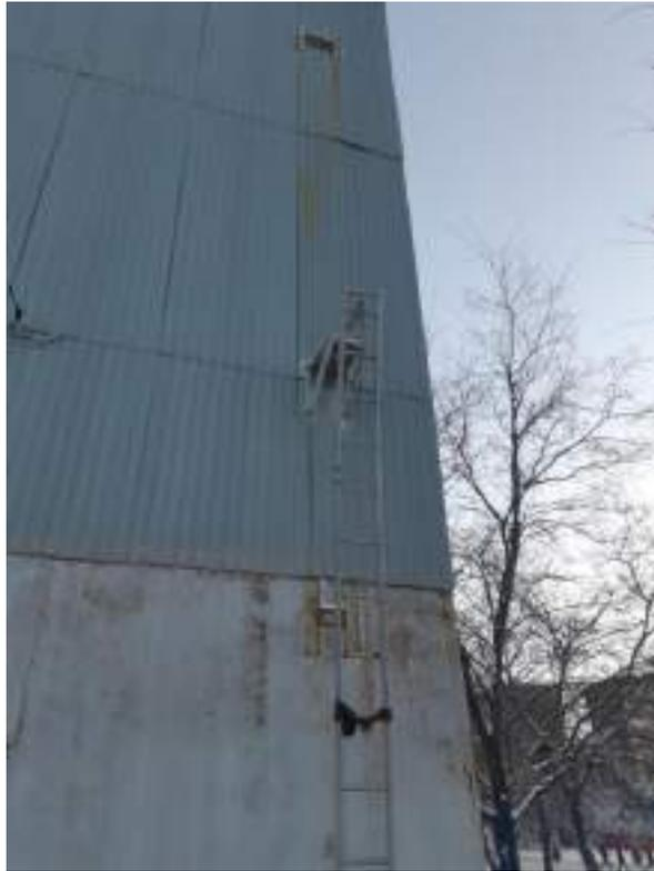
Рисунок 3 – Закрепление штурмовой лестницы за конструкцию стенда на учебной башне
