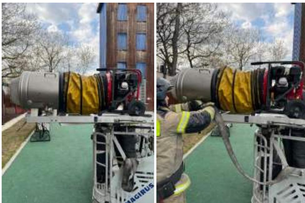
Устанавливаем автолестницу с оператором в СИЗОД на необходимый уровень высоты для подачи огнетушащего вещества. По команде поднимаем обороты вентиляционного устройства и подаем раствор пенообразователя в рукавную линию.
