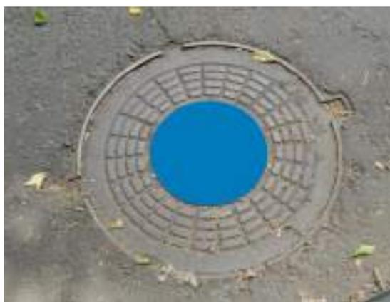
Рисунок 2 – Схема обозначения ПГ
