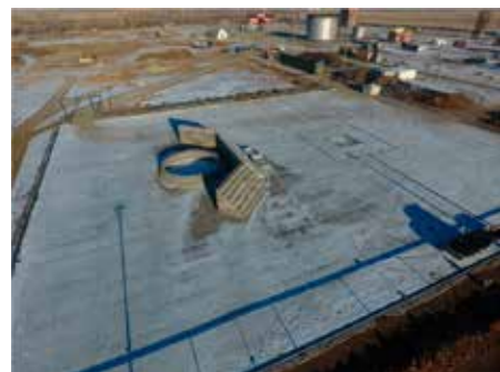
Рис. 4.5. Первый этап: испытательная площадка с инженерной инфраструктурой
