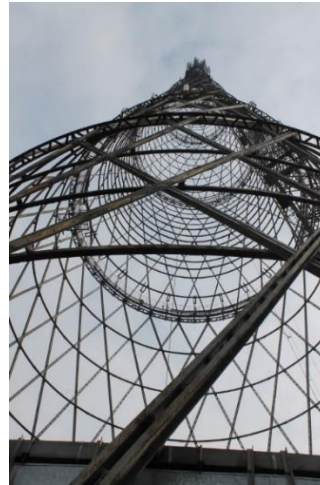
Фото 1.2. Пример башенного сооружения со стальным каркасом
