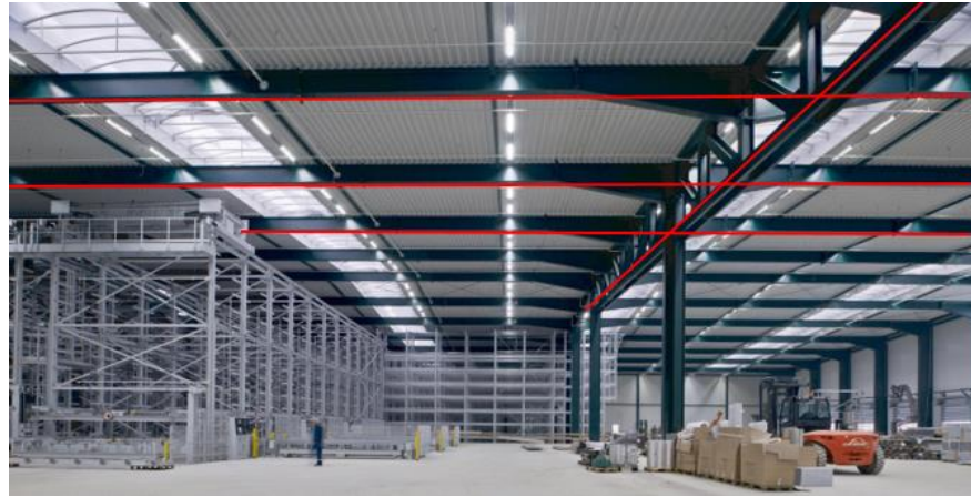
Фото 2.5. Измерение ферм промышленного здания (красными линиями показаны места измерения)
