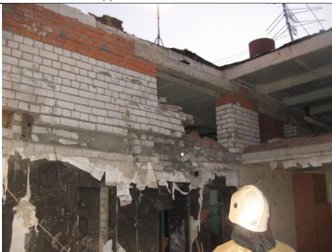
Фото 11. Общий вид поврежденных 4-5 этажей в осях А/11-12 кирпичного здания с 5 по 3 этажи
