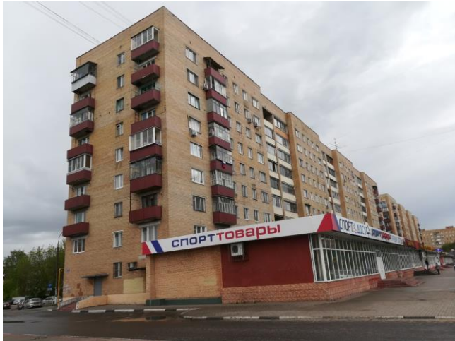
Фото 1.1. Пример типового кирпичного многоэтажного здания
