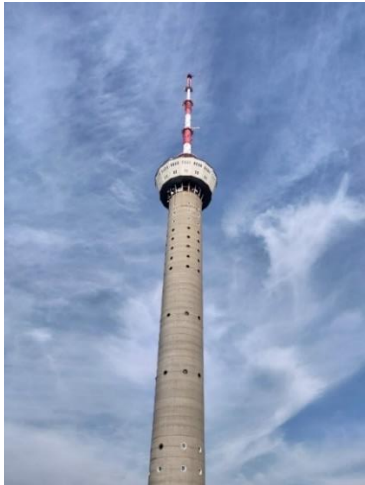
Фото 1.1. Пример сооружения башенного типа смешанного конструктивного исполнения с железобетонными и стальными конструкциями
