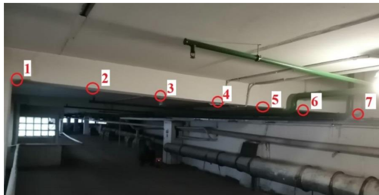
Рис.2.2. Измерение балки на техническом этаже здания (красными точками показаны места измерения)
