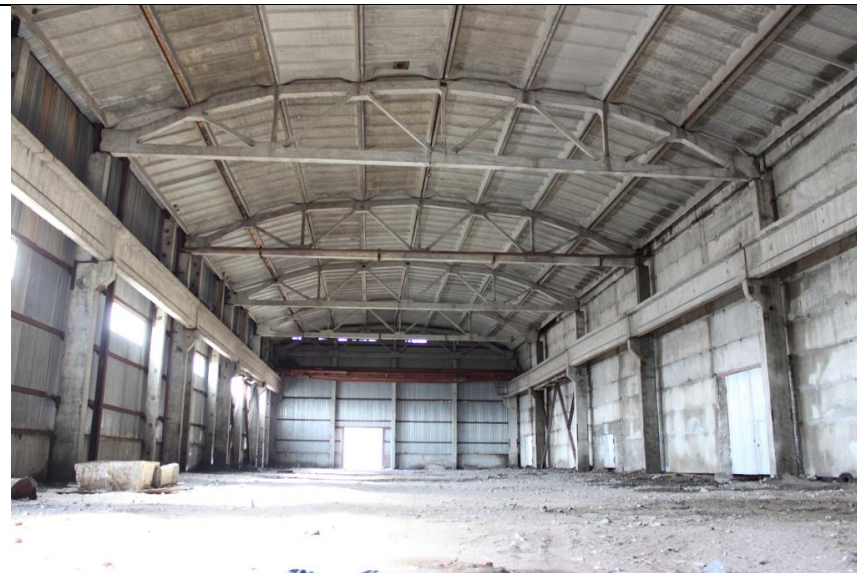
Рис.1.2. Пример типового панельного промышленного здания
