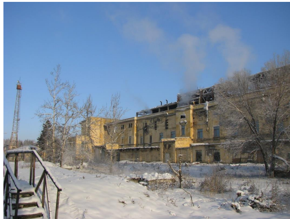
Фото 2. Фасад здания турбинного зала
