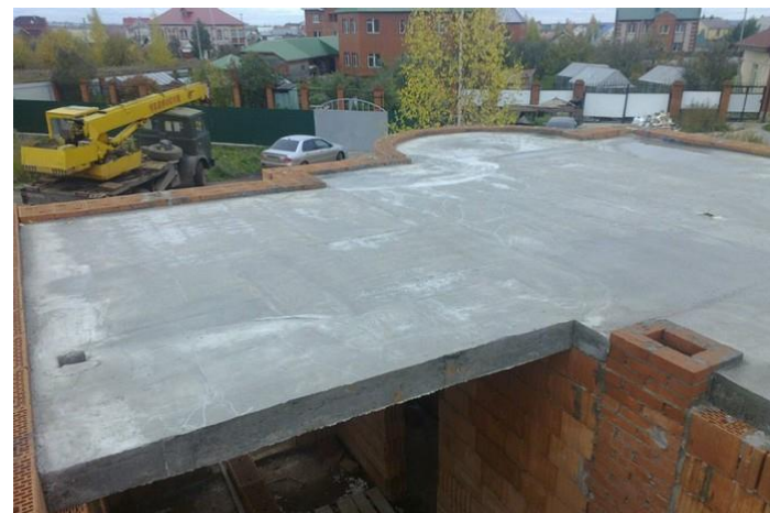
Рисунок 4 – Монолитные железобетонные плиты
