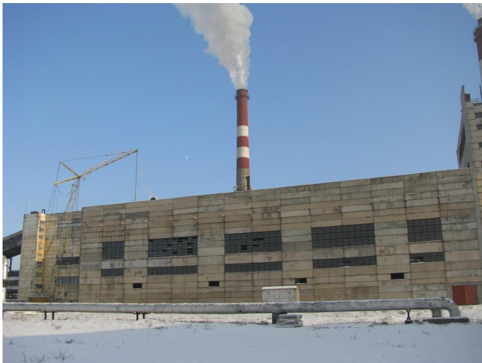
Фото 1. Фасад здания котельной
