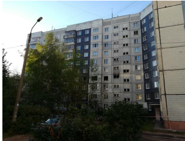
Фото 1.2. Пример типового панельного многоэтажного здания
