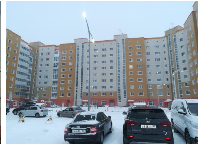
Фото 1.3. Пример типового монолитного многоподъездного железобетонного здания
