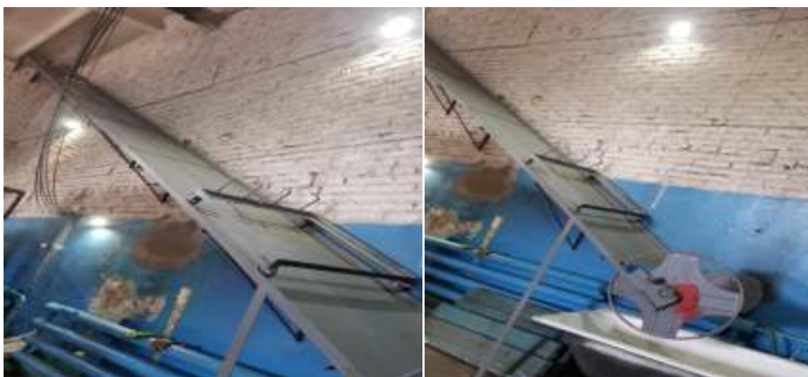
Изображение 3: Стеллаж с тележкой для подъёма пожарных рукавов на высоту и ванна для слива остатков воды из рукавов
