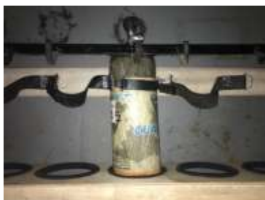
Рис. 4. Закрепление резервного баллона
