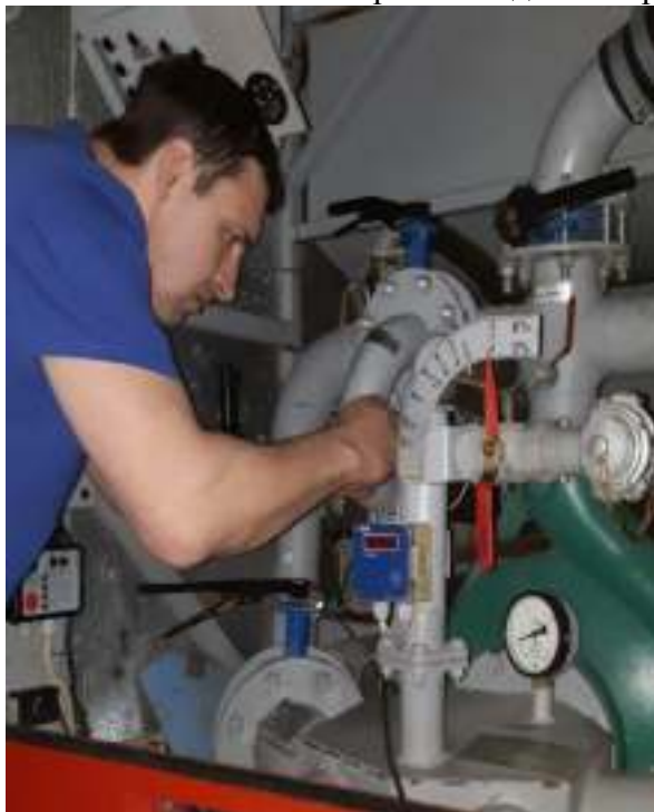
Рис. 1. Установка устройства для обогрева кранов насоса НЦПН 70
