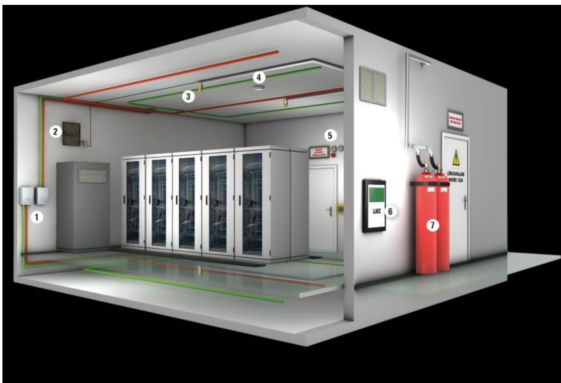
Рисунок 147 – Автоматическая установка газового пожаротушения.
