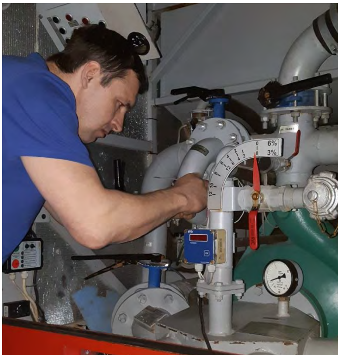
Рис. 1 Установка устройства для обогрева кранов насоса НЦПН 70
