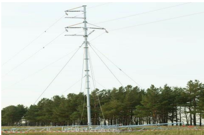
Рис. 7.2. Быстровозводимая и демонтируемая опора ПБМ110-1
