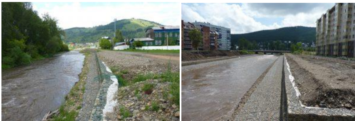
Рис. 6.39. Инженерная защита г. Горно-Алтайска, р. Майма
